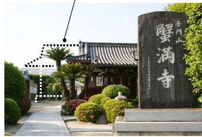
本堂は平成21年末に復元完成予定 観音堂の後に本堂(破線部)
